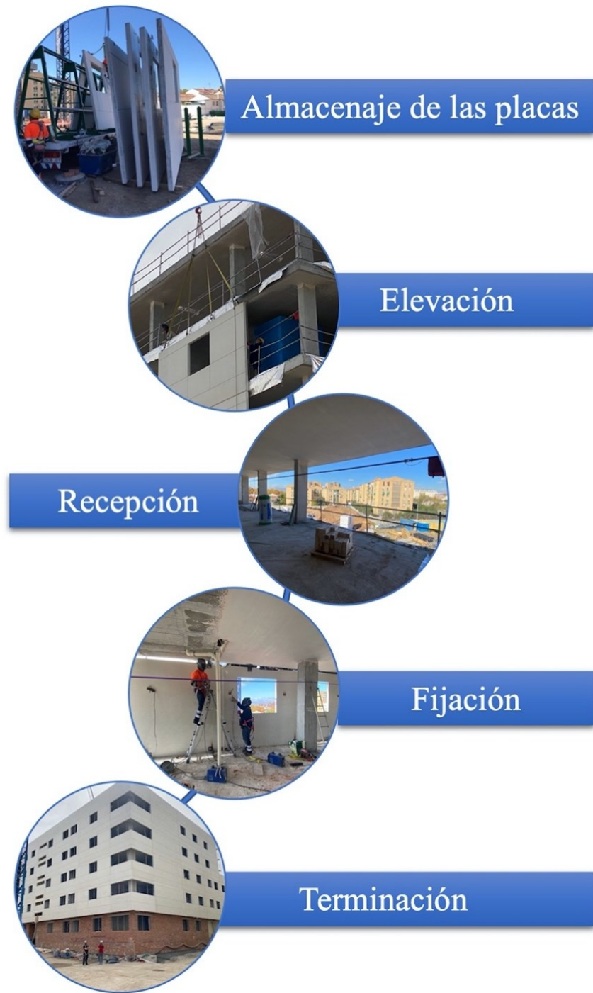
Figura 6. Pasos en la puesta en obra de los paneles de hormigón. Fuente: Elaboración Propia
