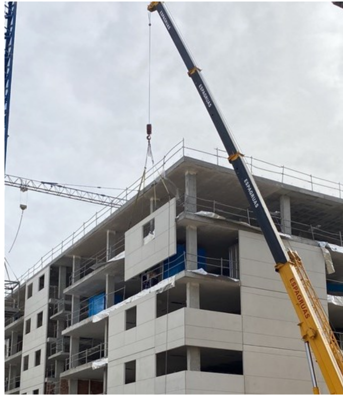
Figura 7. Proceso de puesta en obra de los paneles de hormigón. Fuente: Los autores
