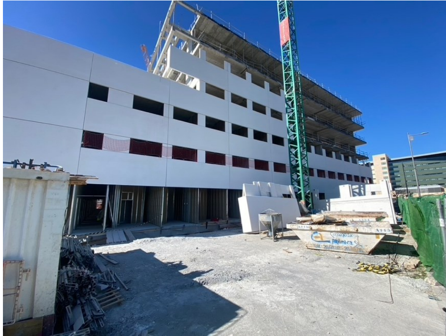
Figura 3. Fachadas prefabricadas. Fuente: Los autores
