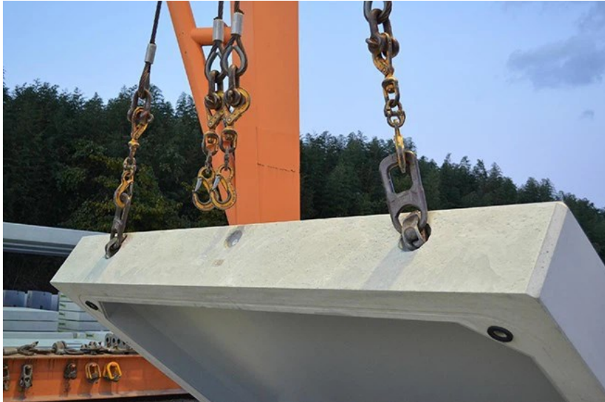
Figura 4. Anclajes de una placa prefabricada. Fuente: https://es.precastconcretemagnet.com
