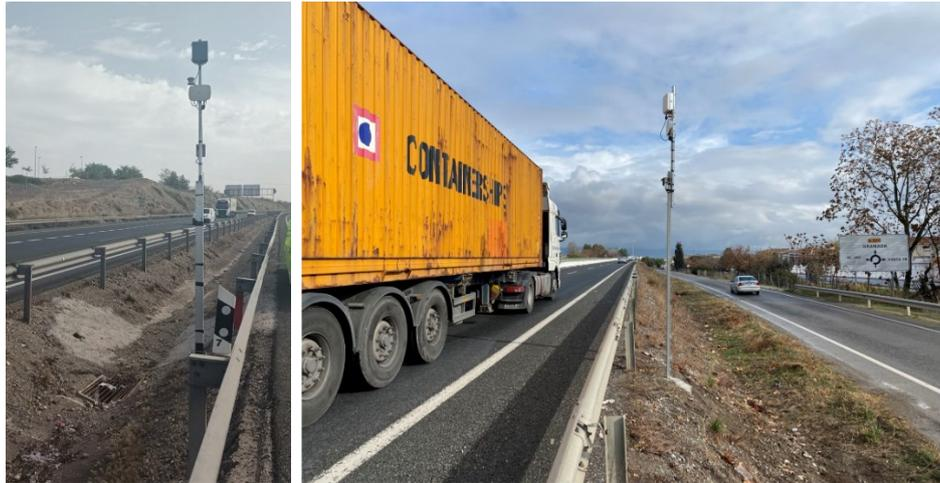
**Figura 4.** Monitorización de gases contaminante (CO<sub>2</sub>, NO<sub>x</sub>, etc.), partículas en suspensión y ruido, temperatura y humedad
