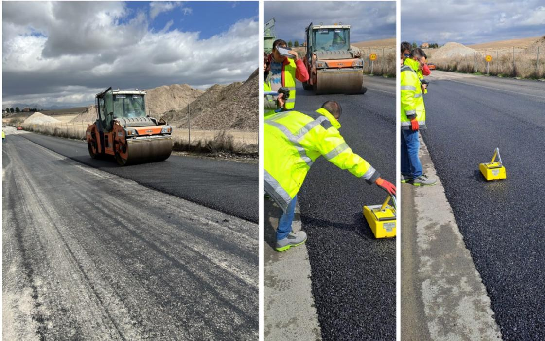
**Figura 5.** Control de densidades in-situ durante la ejecución del tramo de prueba
