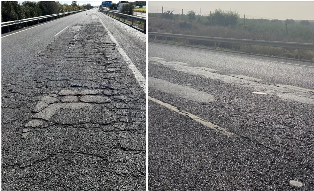
**Figura 3.** Ejemplo de pavimentos deteriorados antes de la actuación MASAI.
