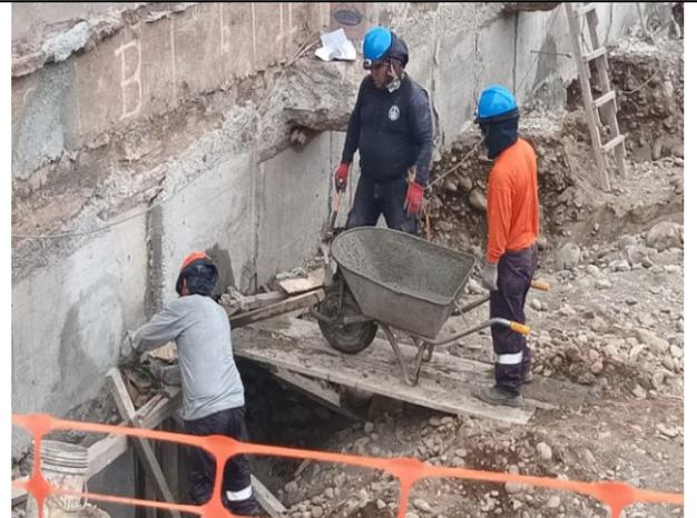
Antes del evento Kaizen: Se realizó el proceso de vaciado de concreto hecho en obra, el cual consiste en construir una rampa que permite realizar el vaciado de concreto por la parte superior del encofrado de la calzada, mediante una cachimba en la parte superior. De esta forma el personal obrero traslada la mezcla por toda la rampa hasta llegar a las cachimbas de cada calzada encofrada.
